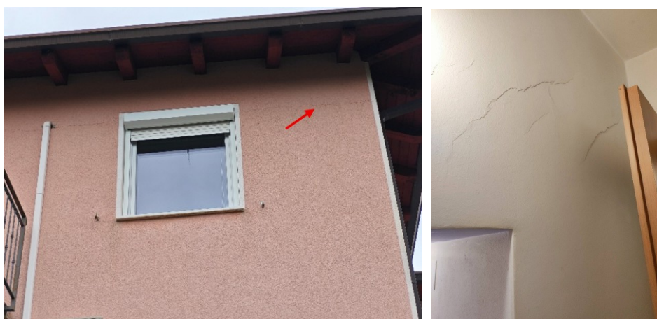
Slika 3 (leva slika): Razpoke na stanovanjskem objektu s hišno številko Hlevnik 5a, južna stena. Slika 4 (desna slika): Razpoke znotraj stanovanjskega objekta s hišno številko Hlevnik 8, severni del objekta, objekt ima še več razpok, tudi v severozahodnem vogalu.
