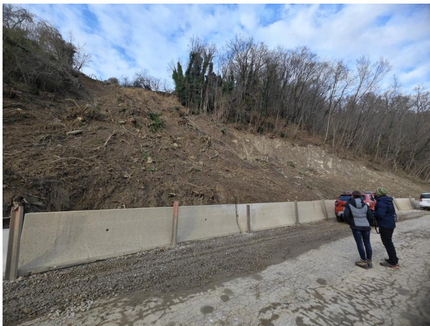
Slika 5: Pogled na plaz od spodaj.
