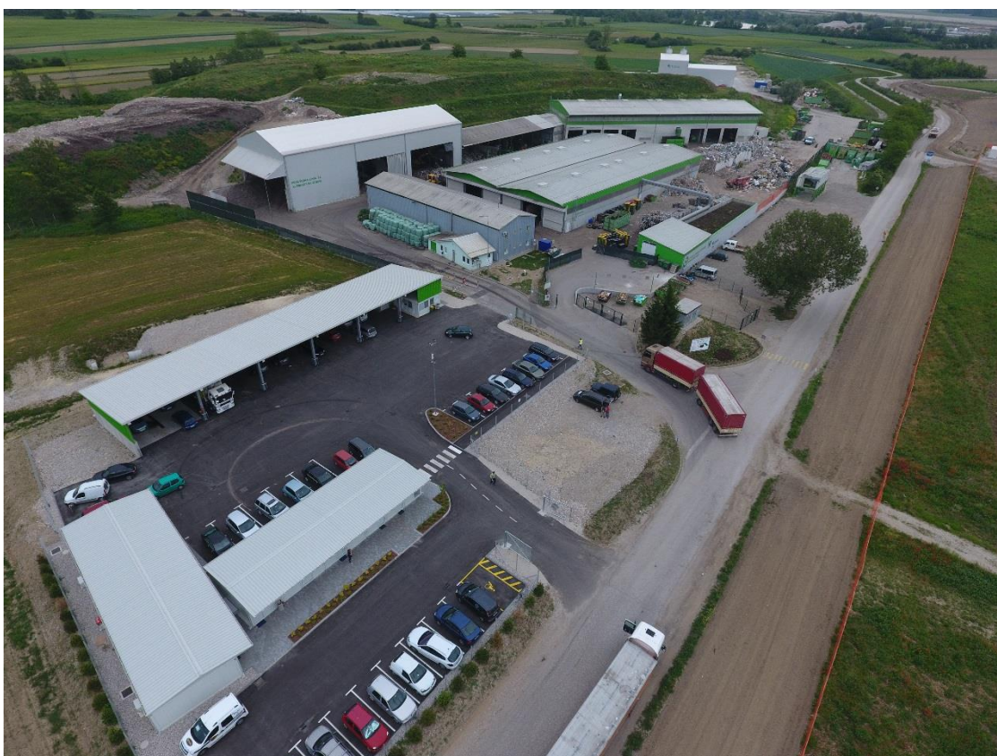
Slika 1: Center za ravnanje z odpadki Spodnji Stari Grad
