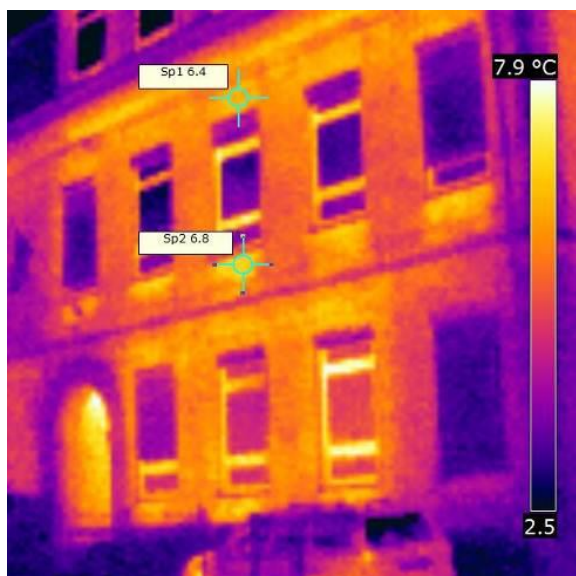
Slika 25: Termografija fasade POŠ Kojsko 1
