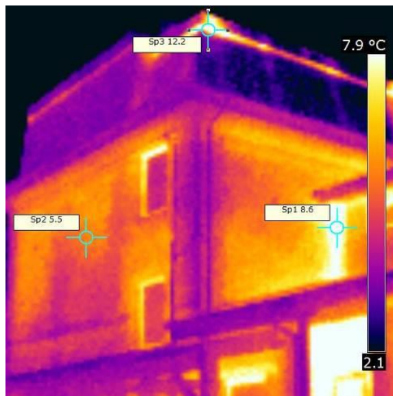
Slika 26: Termografija fasade POŠ Kojsko 2
