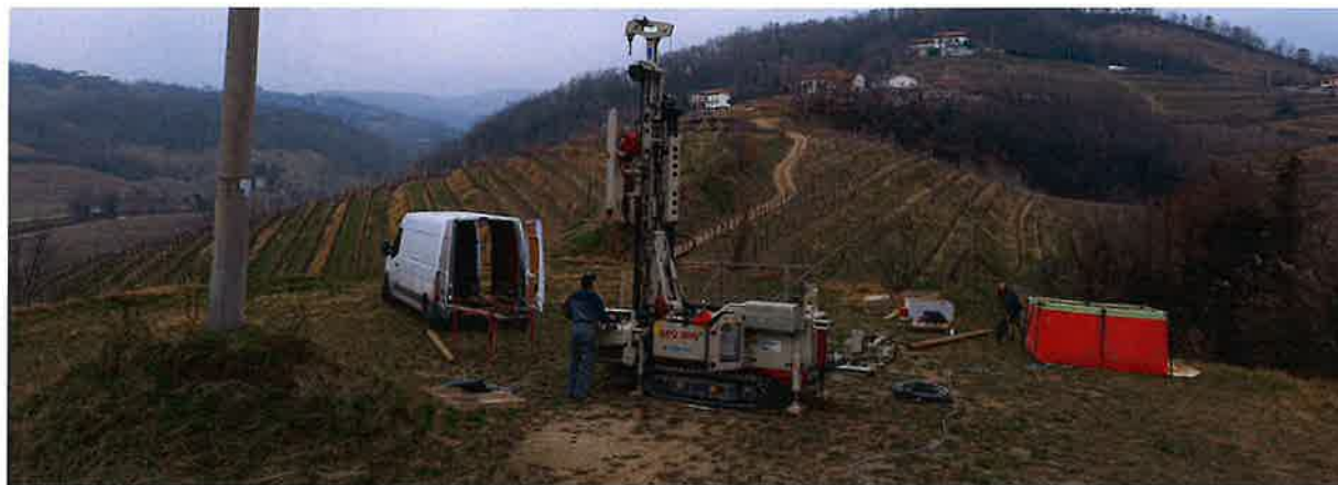
Slika 4: Izvedba vrtalnih del.
