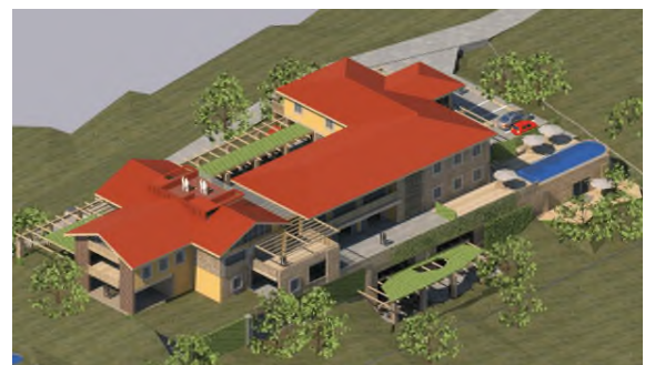
pogled s severozahoda
