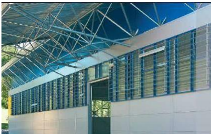
Slika 23: Brisoleji
