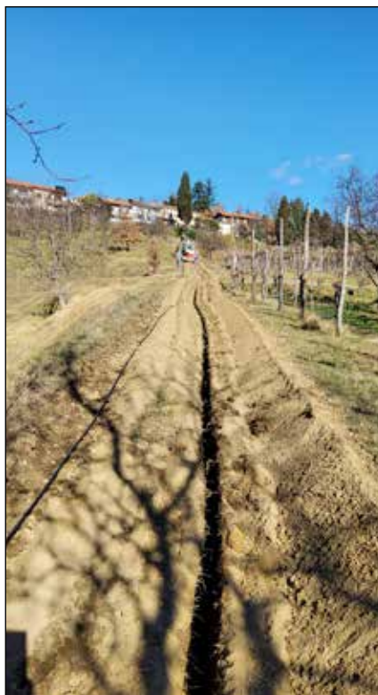
Gradnja omrežja do uporabnikov v naselju Drnovk
