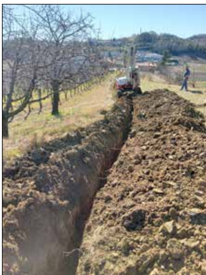
Gradnja omrežja do uporabnikov oz. ti. sekundarnega omrežja v naselju Drnovk
