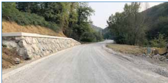
Obvoznica Kojsko v izgradnji.
