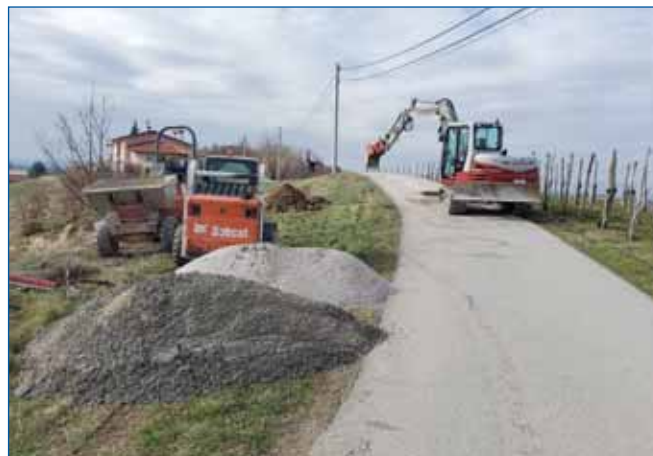
Gradnja omrežja med naselji iz Višnjevika proti Krasnem
