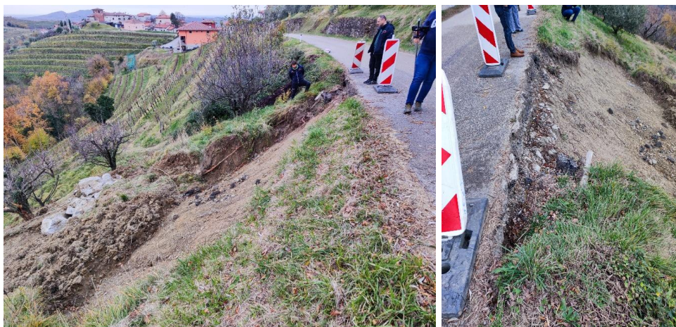
Slika 1 (leva slika): Usad pod cestiščem.
