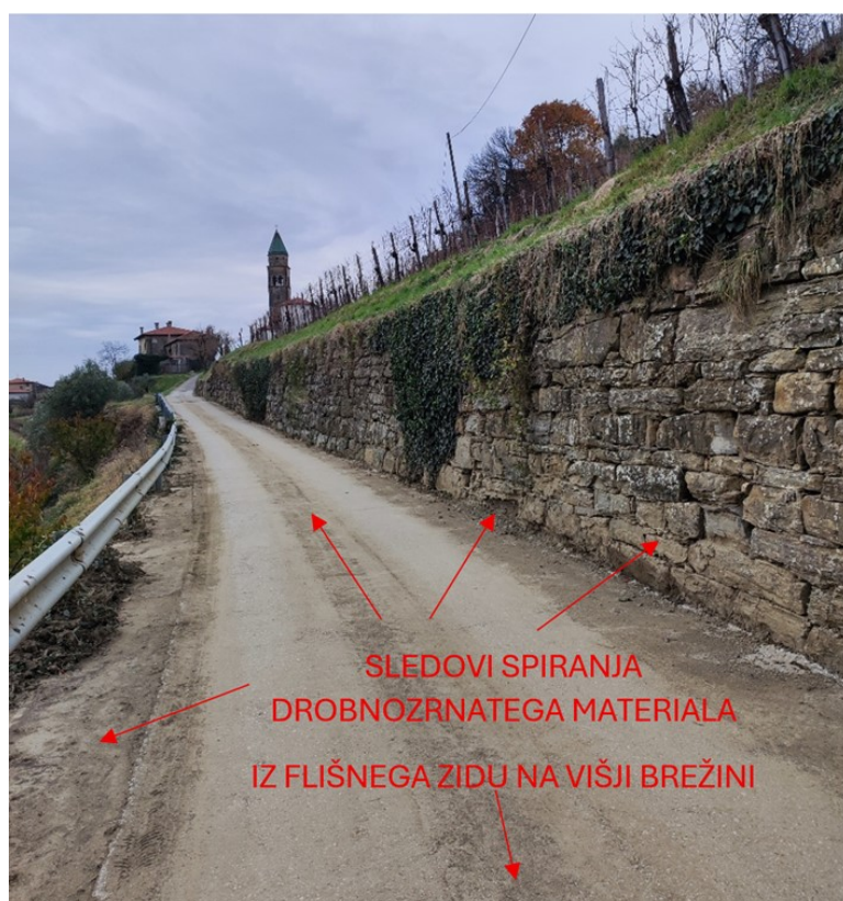
Slika 2: Sledovi drobnnozrnatega materiala, ki se spira skozi reže flišnega zidu.
