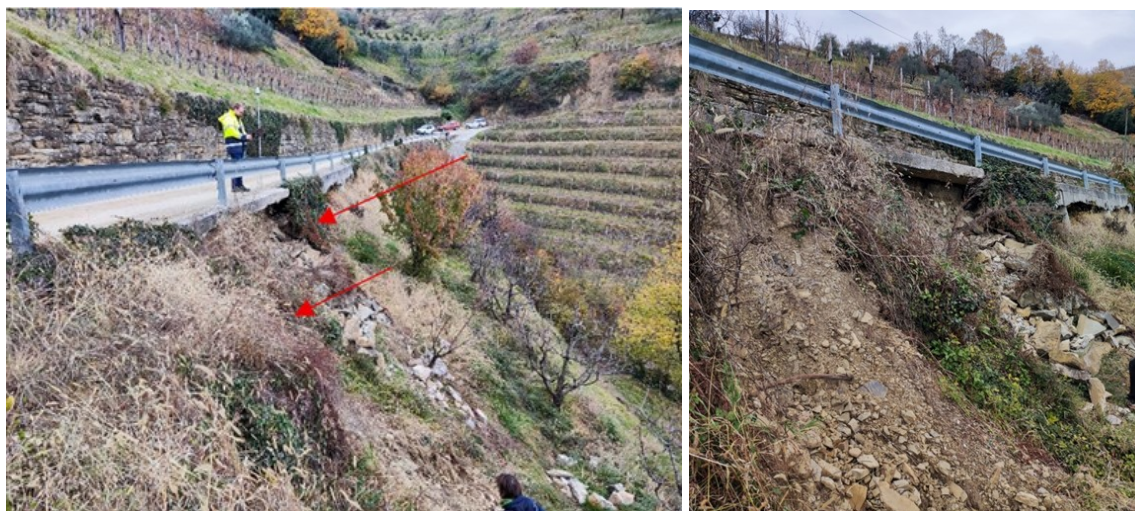
Slika 1: Pobočni premik – podor sprožen s hidravlično porušitvijo. V okolici je več plazov in erozije, ki niso primarna tema tega poročila.
