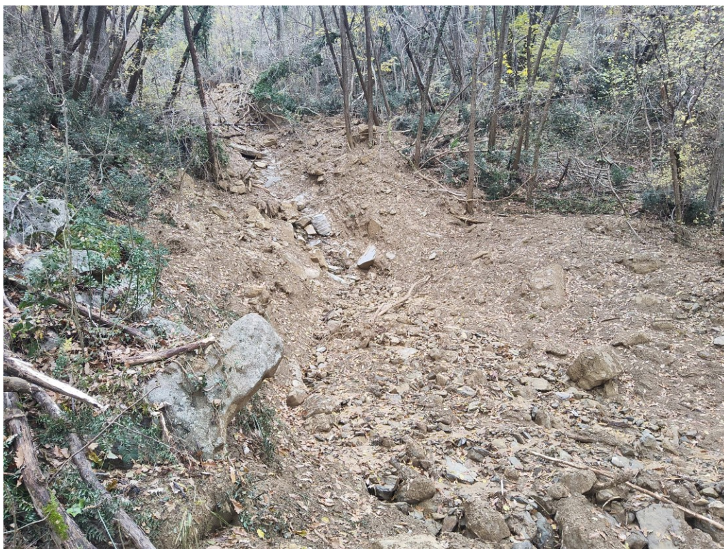
Slika 12: Akumulacija materiala drobirskega toka v grapi pod plazom.
