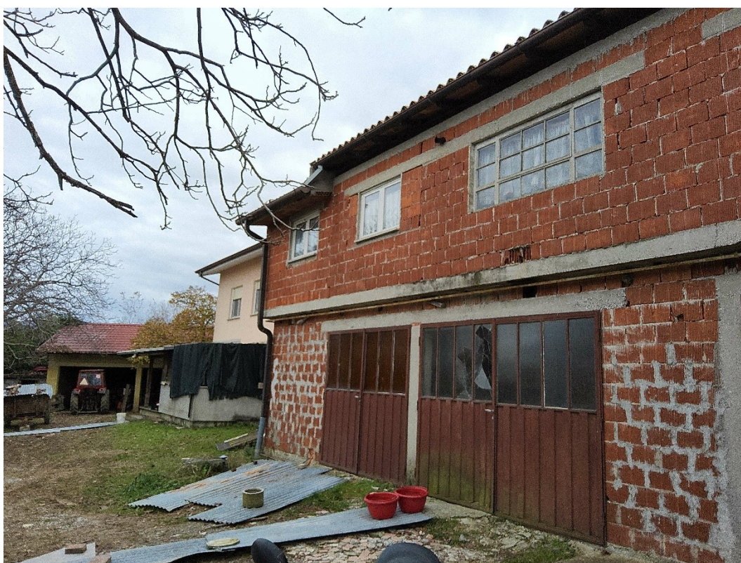
Slika 5: Neurejeno odvodnjavanje meteornih vod.
