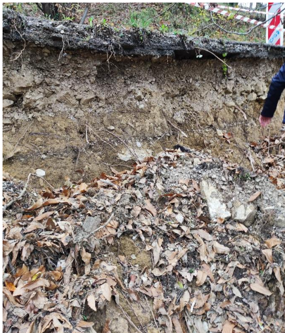
Slika 4 (leva slika): Plasti nasutja ceste in v spodnjem delu plasti premeščene preperine. Slika 5 (desna slika): Blaga globel približno nad osrednjim delom plazu – nad cesto.
