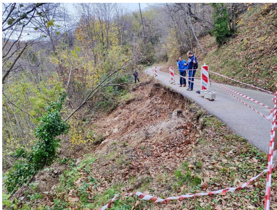
Slika 1: Zgornji del plazu; zgornji odlomi rob je na robu lokalne ceste.
