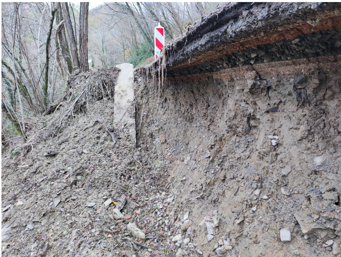
Slika 2: Plazina, drobnnozrnate zemljine in tampon ceste.
